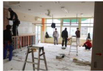
保育室工事の様子 大工さんが大勢で作業
